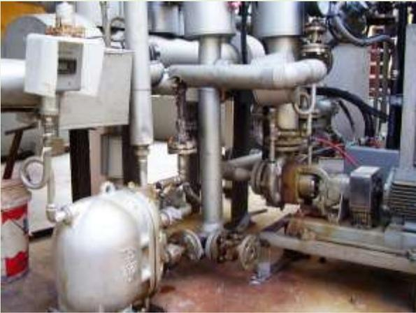
蒸気ドレン回収用ポンプを設置し、熱回収に努力しています。
