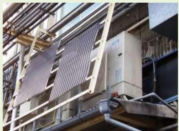
エアコン設定温度は夏28℃、冬20℃に設定。室外機に日よけを設け、定期的に洗浄し省エネを進めています。
