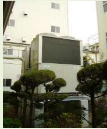
MM・開発棟には、ガスヒートポンプエアコンを設置し、夏季昼間の電気需要の低減を図っています。
