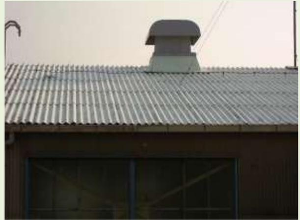
スレート屋根には遮熱塗料・断熱塗料を塗装しています。
